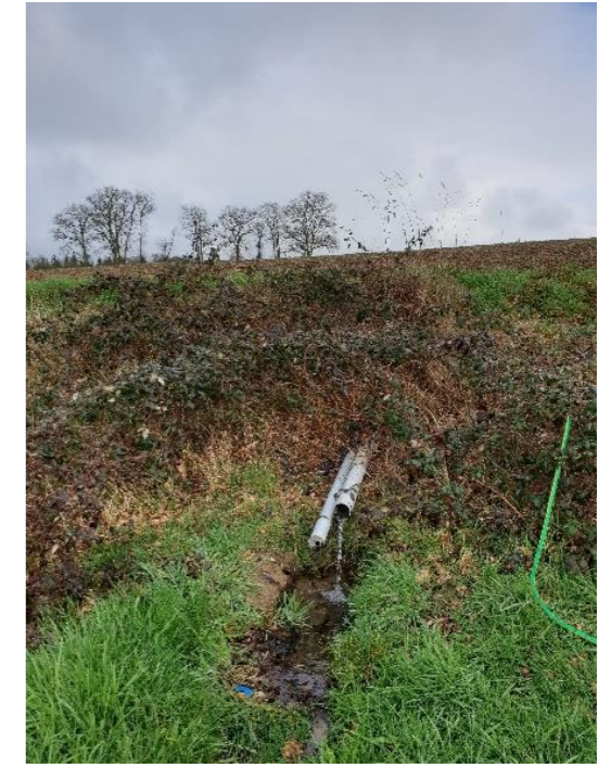
Drainage du sol à l'aide d'un drain
