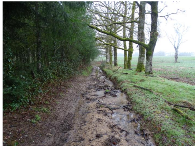
Figure 24 : Ruissellement d'eau (Prise de vue 1)
